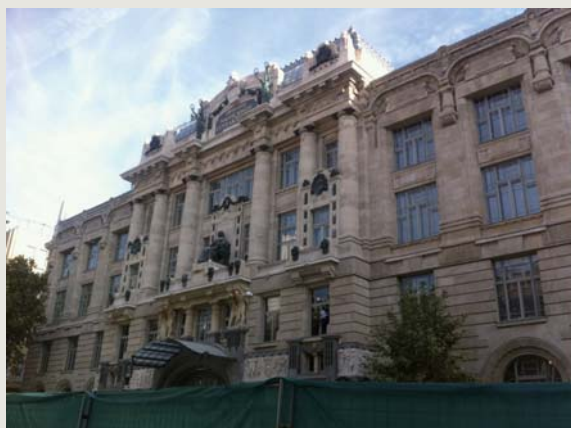
改修工事最終段階のリスト音楽院本校舎
